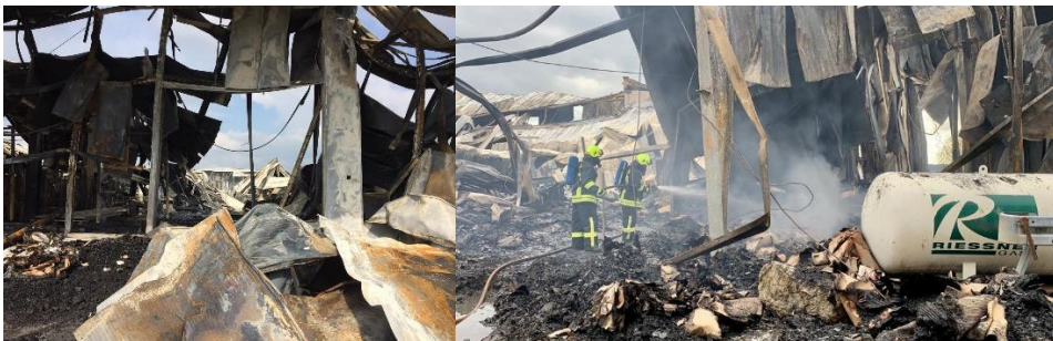
Trotz Totalverlust des Gebäudes konnte ein Gastank erfolgreich geschützt werden
