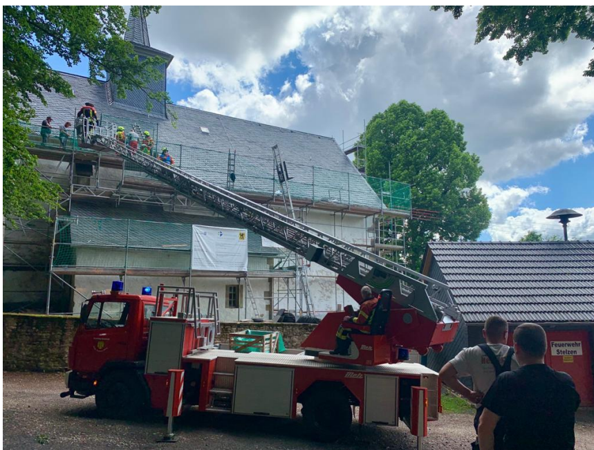
Personenrettung an der Kirche Stelzen, ein Arbeiter musste mittels Drehleiter vom Baugerüst gerettet werden
